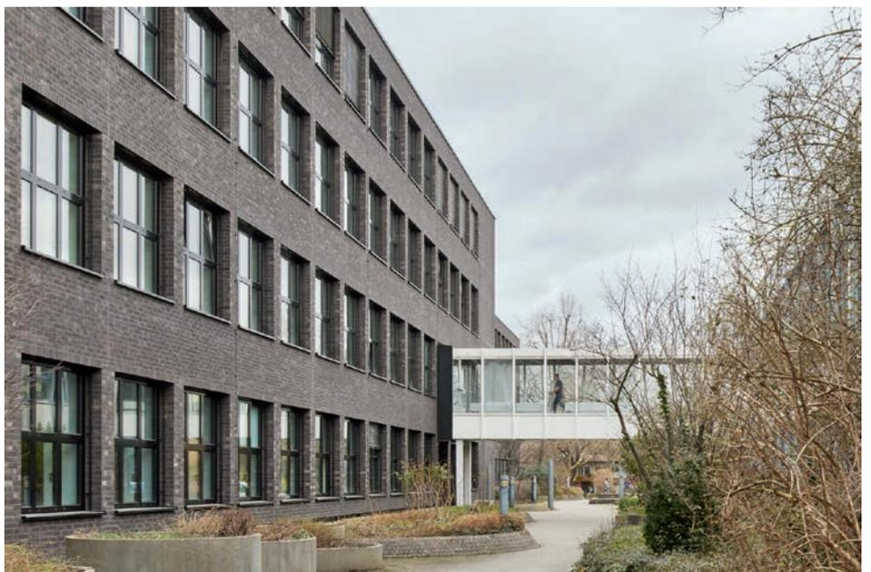
Sanierungsmaßnahmen in zwei Bauabschnitte geteilt. Um den laufenden Schulbetrieb aufrecht zu erhalten, wurden die einzelnen Bauabschnitte nochmals zu jeweils zwei Geschossen zusammengefasst. Nach der Demontage der bestehenden, vorgehängten hinterlüfteten Metallfassade
